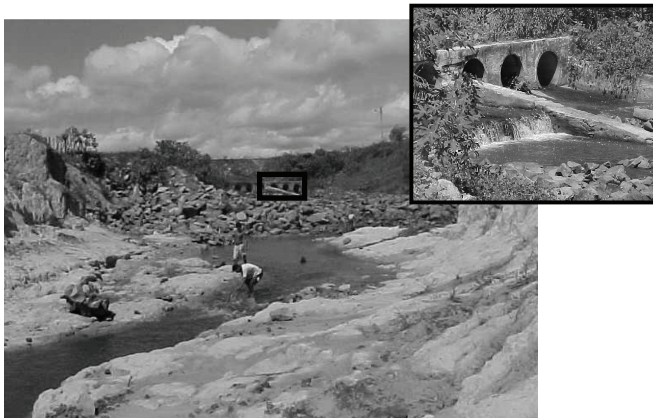
FIGURA 2: Vertedouro construído em 2003 para regularização do volume da Lagoa do Catú para fins de abastecimento e controle de inundações.
