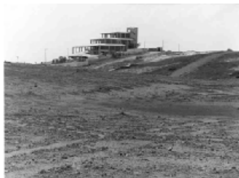
Figura 12 – Compactação das dunas fixas com saibro para criação artificial de solo. Maio de 2002. Fotos de Flávio R. do Nascimento.
