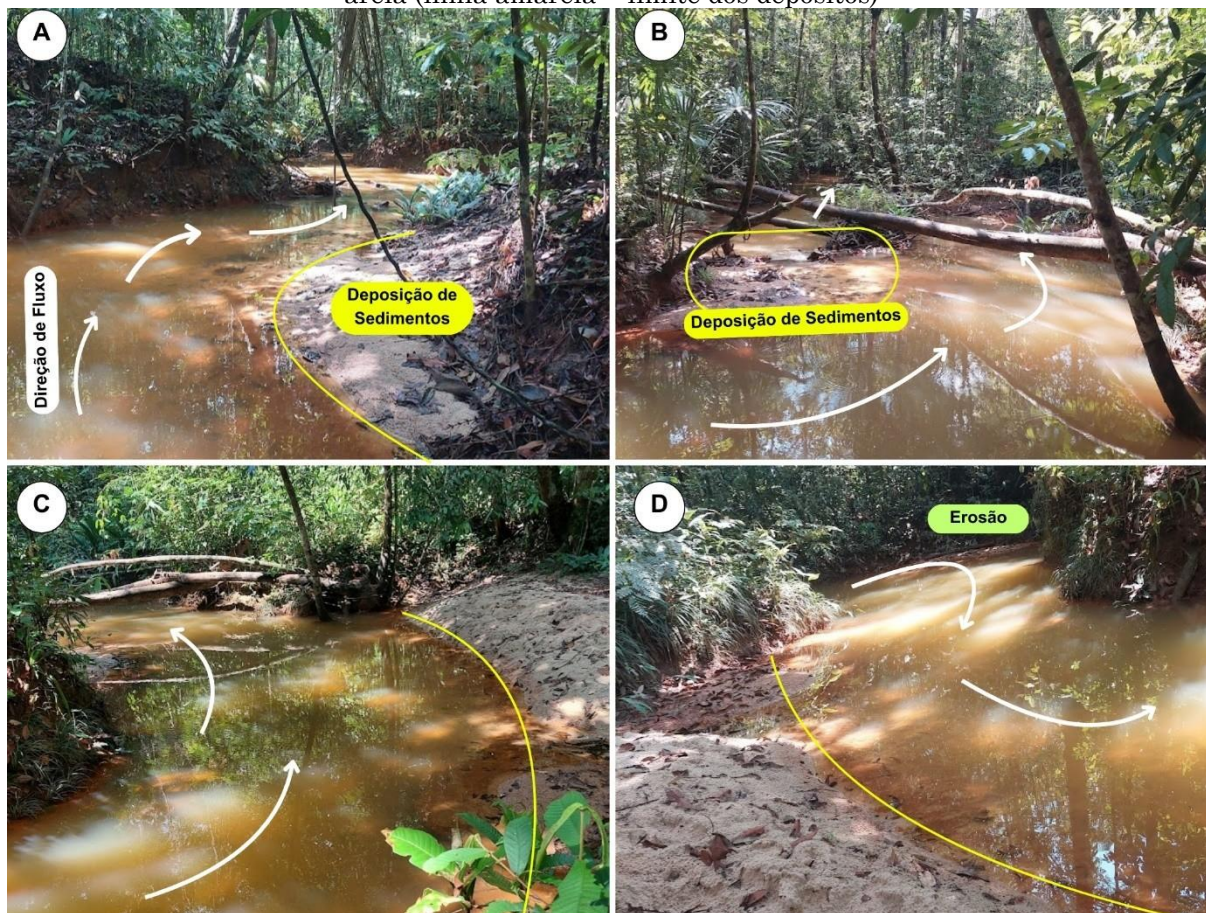
Figura 5 – Feições morfológicas. A) Formação de bancos de areia na margem direita do igarapé Água Branca. B) Deposição de sedimentos na margem esquerda do igarapé Água Branca e a conexão com a ilha no meio do leito. C) e D) Processos de erosão lateral e deposição, com a formação de bancos de areia (linha amarela = limite dos depósitos)
