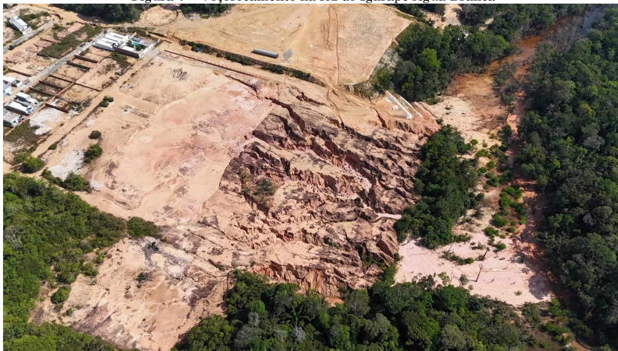
Figura 7 – Voçorocamento na foz do Igarapé Água Branca
