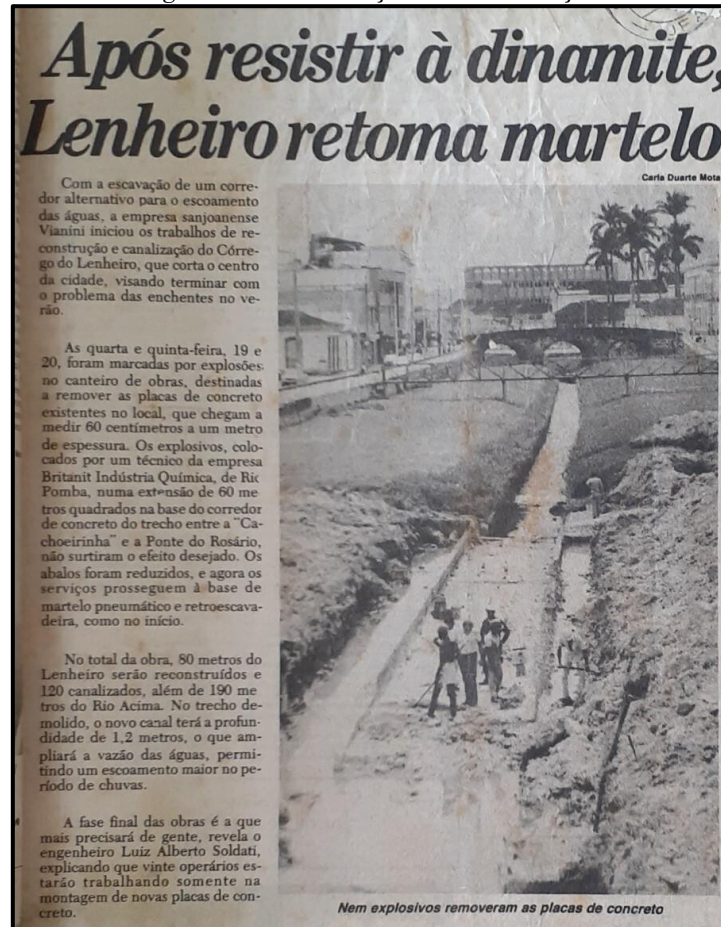
Figura 10 – Demolição da canalização.
