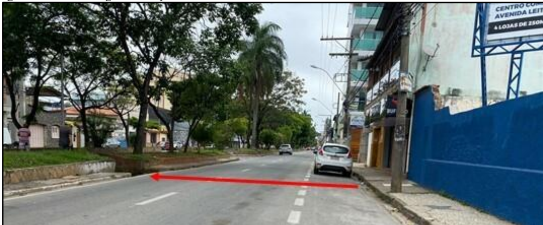
Figura 22 – Córrego da Voçoroca do Dom Bosco canalizado sob a Avenida Leite de Castro.
