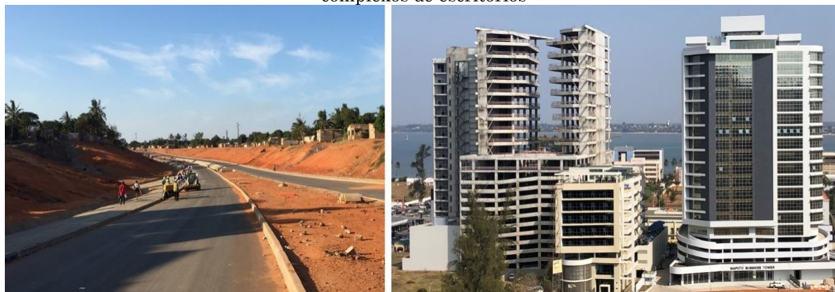
Figura 9 - Requalificação da avenida “Julius Nyerere” e novos complexos de escritórios
