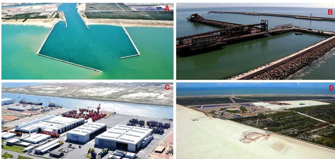
Figura 2 - Instalações e construções do Porto do Açú: A (terminais TX1 e TX2), B (quebra-mar no TX2), C (empresas instaladas ao longo do canal de navegação), D (aterro hidráulico construído perto da área de restinga).
