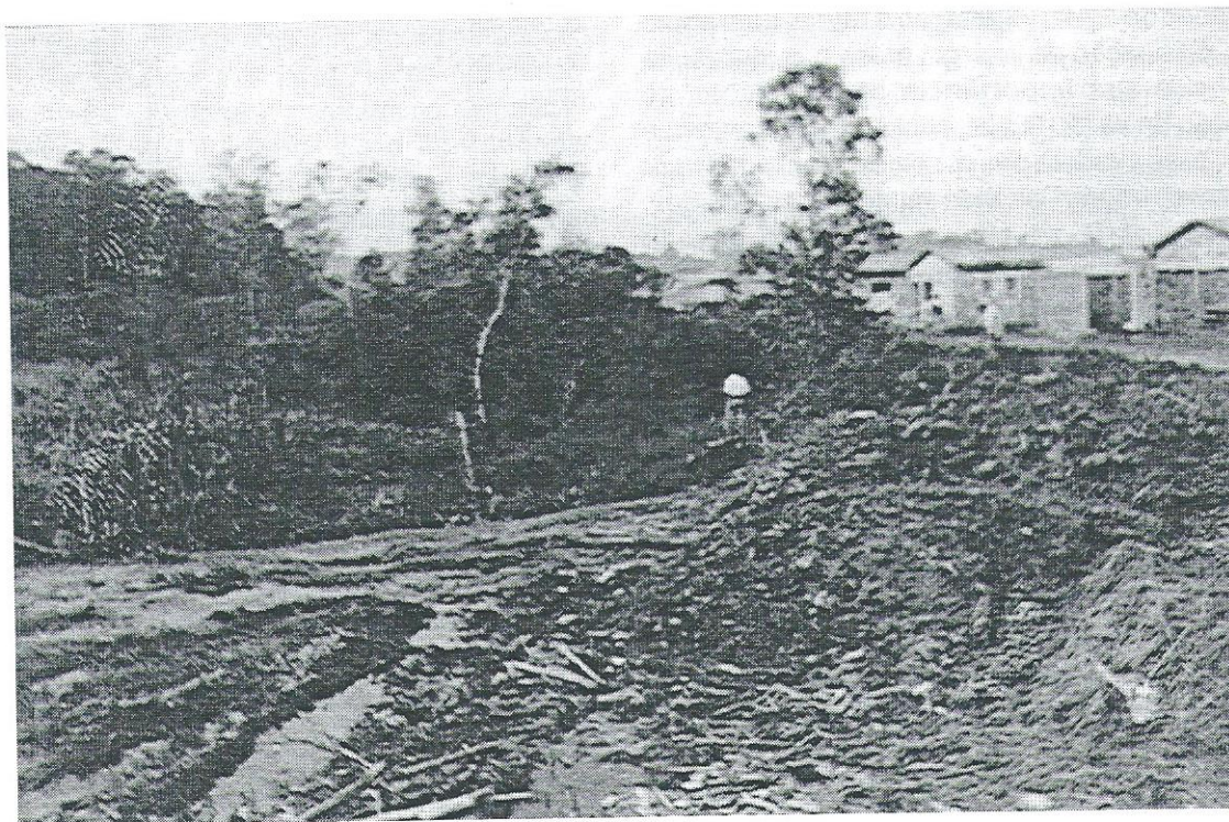
FOTO 2 - Área alagada, localizada na parte esquerda-central da fotografia, demonstra um setor remanescente da antiga lagoa, situada no leito maior do Ribeirão Claro. O aterro, observado ao centro e à direita da fotografia, entulhou por rejeitos e lixos de origens diversas a lagoa e portanto a Área de Preservação Permanente. Esse aterramento é efetuado com convicção da Prefeitura Municipal, destruindo as áreas preservadas pelas Legislações Federal, Estadual e Lei Orgânica do Município.
