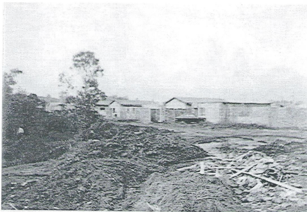
FOTO 3 - O desnível topográfico registrado pela fotografia, demonstra que o Leito Maior do Ribeirão Claro foi aterrado com variações de 1,50m a 2m de entulhos, lixo doméstico, lixo de postos de gasolina e outros rejeitos de várias origens. Com isto o nível topográfico do aterro retirou as habitações do setor alagado inerente à área. Contudo, o aterro não foi suficiente para remover a umidade do local, que tenderá a se manifestar em sua superfície e também será atingido pelas águas de cheias do Ribeirão Claro. Salienta-se a ressurgência de esgoto na várzea.
