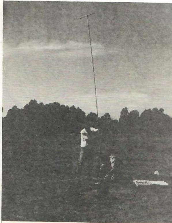
Figura 2 - Trado manual utilizado para perfurações até 6 metros de profundidade, para coleta de amostras de solos e instalação de medidores de nível d'água.
