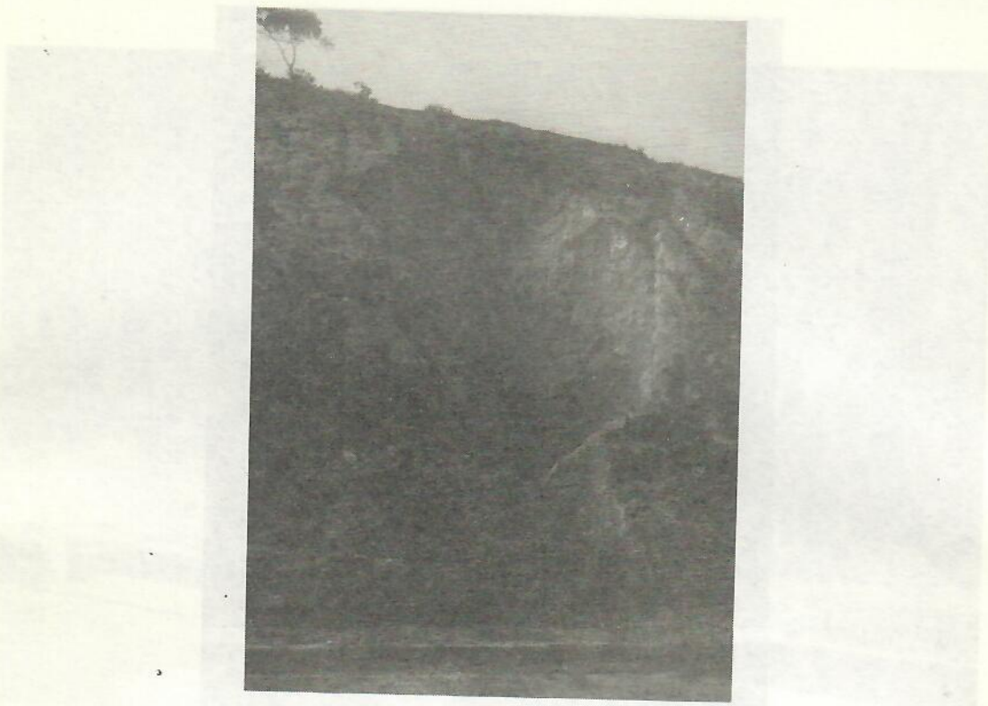
Foto 5 - Deslizamentos ocorridos em maio de 1989. Observa-se a instalação de processos erosivos secundários.
