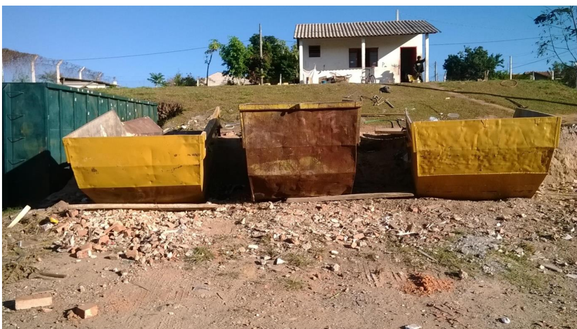
Figura 3. Caçambas para recebimento de RCC, resíduos volumosos e podas de árvores localizadas no interior de um Ecoponto em Limeira/SP.
