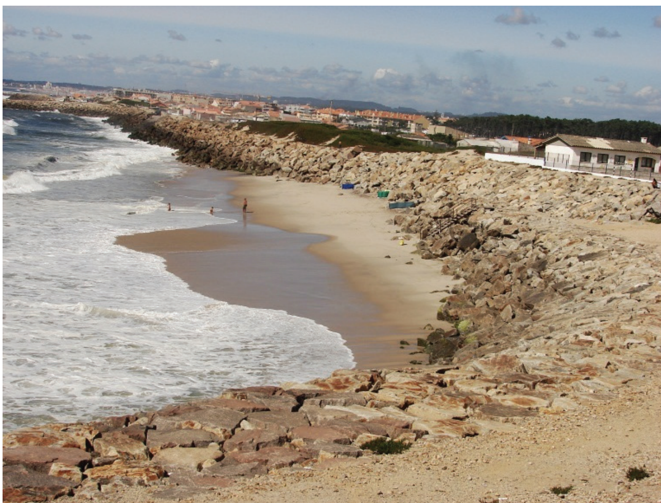
Figura 6. A artificialização do litoral com a construção de obras de proteção em Cortegaça
