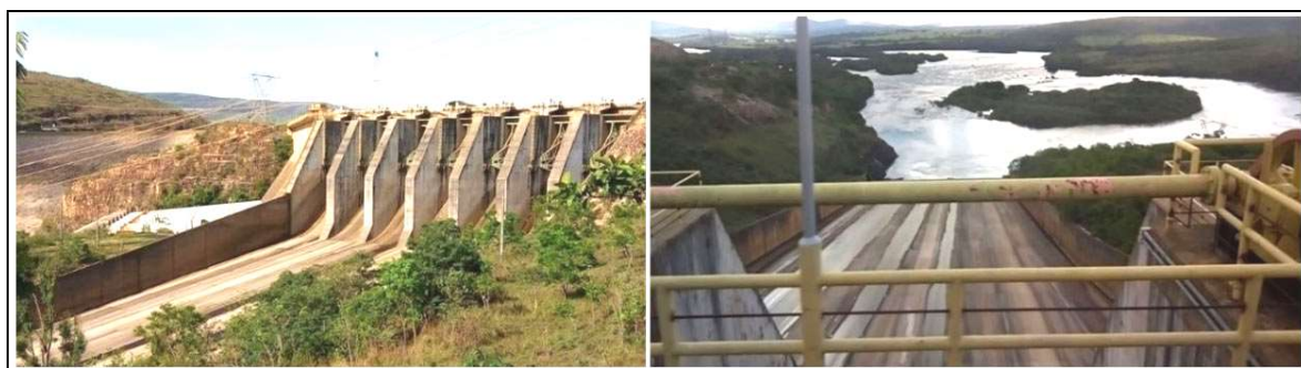
Figura 4: Vertedouro da barragem do reservatório de Furnas, visão panorâmica (esquerda) e de montante para jusante (direita). Fonte: Acervo dos autores.
