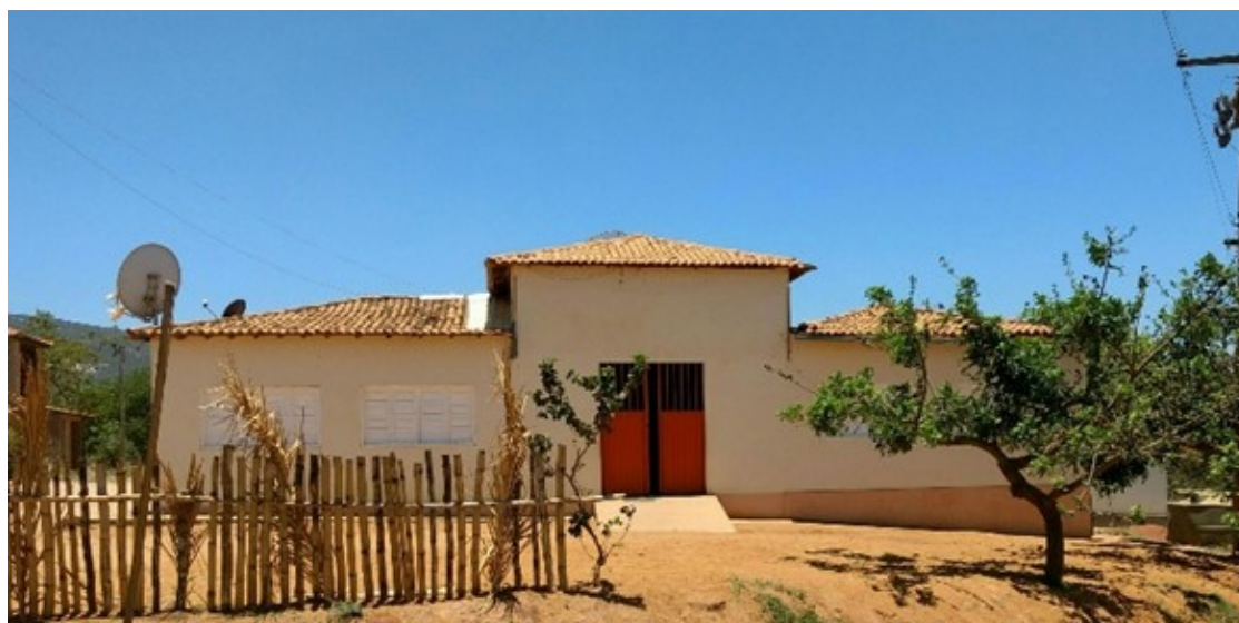
Figura 1: Fachada da Escola de 1º Grau Dom Manoel Raimundo de Melo. Fonte: Arquivo pessoal dos autores, 2019.
