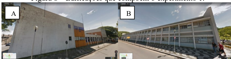
Figura 8 – Edificações que compõem o experimento 1.
