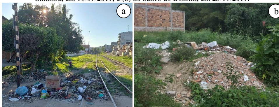
Figura 8 - Pontos de acúmulo de entulho e lixo, espacializados digitalmente durante a visita de campo: (a) no bairro do Sinimbu, em 16/07/2019; e (b) no bairro do Bonfim, em 23/09/2019.
