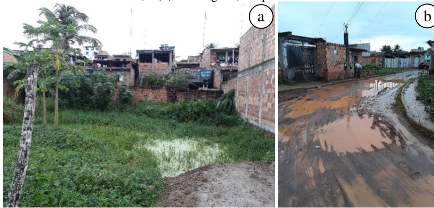
Figura 9 - Pontos de alagamento devido às chuvas, registrados no bairro da Caixa D'Água, em 19/06/2019: (a) terreno alagado, em meio a área residencial; e (b) rua alagada, na qual foram encontrados anfíbios e parasitas.
