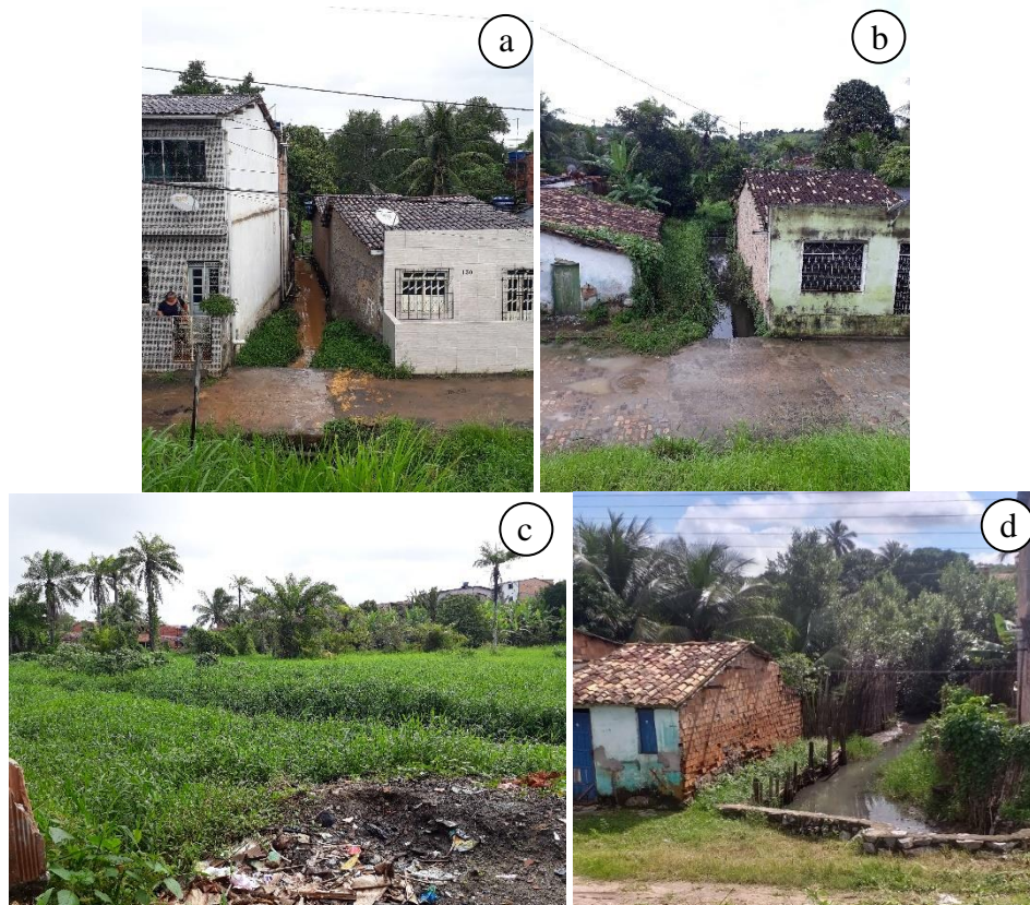
Figura 7 - Bairro do Pilar, pertencente a USF do Derba, situado no setor jusante do rio Subaé, que sofre constante influência das oscilações de maré, devido ao seu deságuar na Baía de Todos os Santos – BTS: (a), (b), e (c) apresentam diversos pontos com áreas alagadiças; e (d) deságuar de água pluvial e esgoto em córrego – registros de 07/10/2019.
