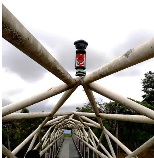
Figura 7 – Receptor GNSS rover e prisma GPR111 sobre a estrutura.
