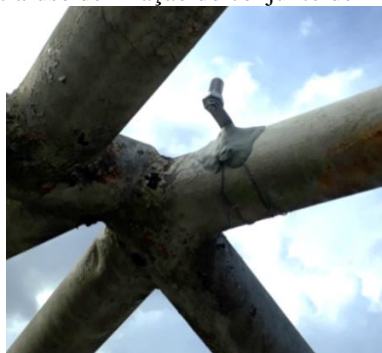
Figura 4 – Parafuso de fixação do conjunto de monitoramento.
