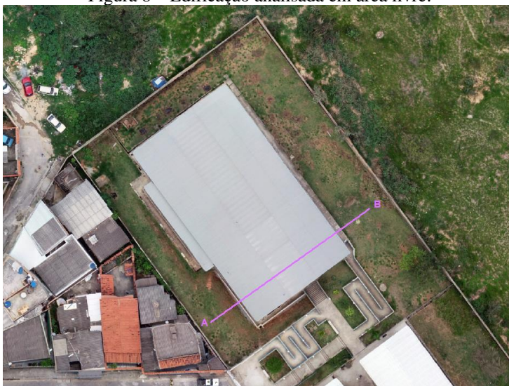
Figura 8 – Edificação analisada em área livre.
