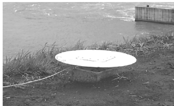
Fig. 1- Antena fixada na crista da barragem de terra
