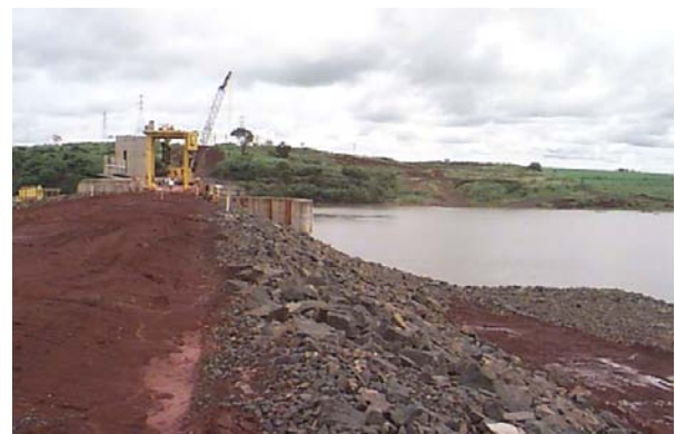
Fig. 3 – Guindastes e estruturas metálicas próximas ao ponto MSG0
