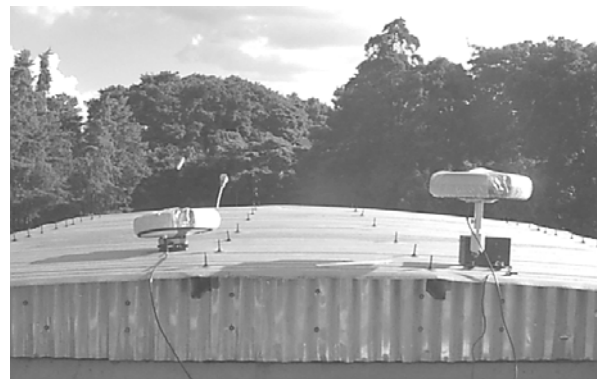
Fig. 9 - Antenas JPS Regant_SD_E choke-ring na cobertura da caixa de água do Departamento de Transportes
