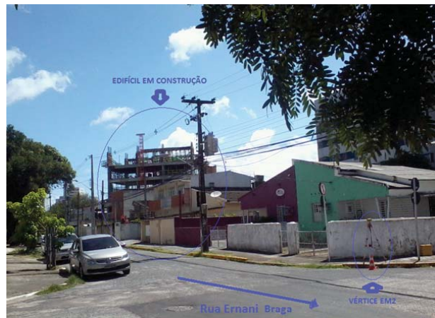
Fig. 6 - Edifício em construção e ocupação GNSS do vértice EM2. Foto: Novembro 2013.
