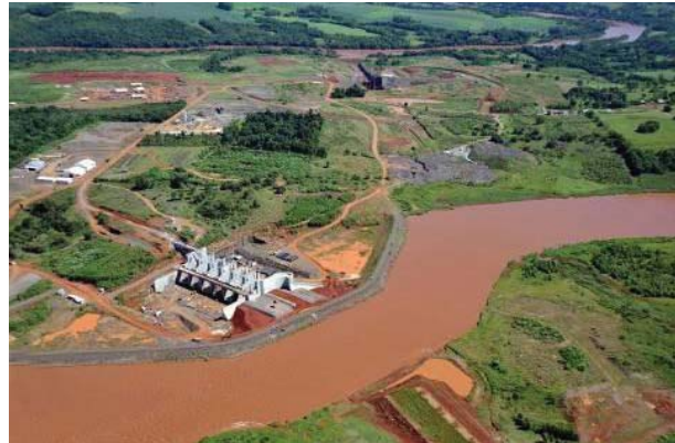
Fig. 1 – UHEPSJ: Fotografia Panorâmica. Fonte: Eletrobras Eletrosul (2011).
