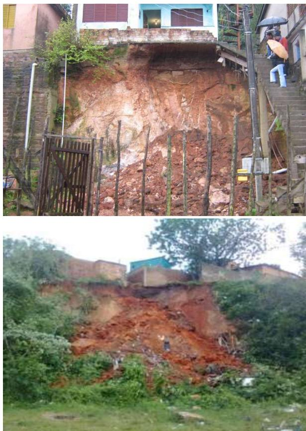
Fig. 6 - Escorregamentos planares deflagrados pela ação antrópica: (a) Talude de corte com inclinação excessiva na Rua Dallas em 2007. O substrato é constituído por solo saprolítico do granito Santana, com cerca de 30 cm de espessura; (b) Encosta natural na Rua São Guilherme em 2012, onde esgoto e entulhos eram lançados diretamente na encosta. Neste local, o solo residual arenoso do granito Ponta Grossa possui em torno de 1 m de espessura. Fonte: imagens cedidas pelo PAR (2013).
