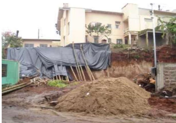
Fig. 7 - Escorregamento planar em talude de corte com geometria inadequada e sem cobertura vegetal em área de ocupação regular. Rua Prof. Antônio José Remião em 2008. Fonte: imagem cedida pelo PAR (2013).
