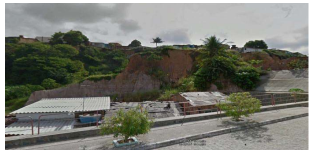
Fig. 5 - Setor de risco R3: Aglomerados subnormais em encostas com falta de cobertura vegetal.
