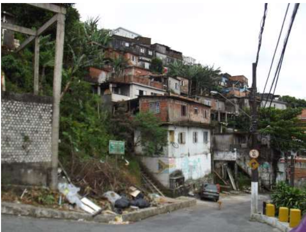
Fig. 5 - Edificações subnormais em área de encosta. Freitas (2015).
