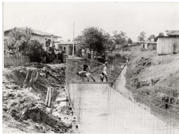
Fig. 3a - Trecho da obra de canalização do Rio Criciúma em concreto armado, década de 1950.
