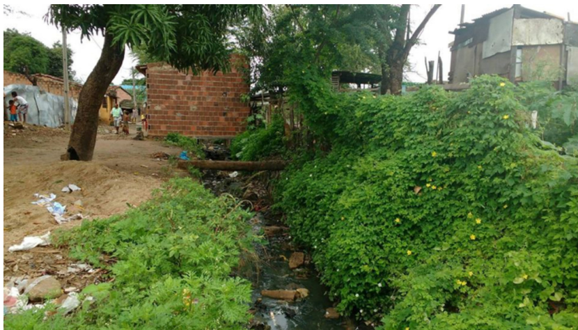
Figura 3: Córrego de esgoto com ausência de saneamento, 2017
