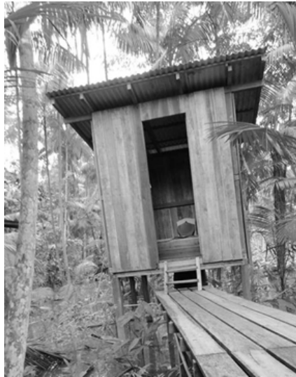
Figura 4 – Estrutura em madeira do Banheiro Ecológico Ribeirinho.
