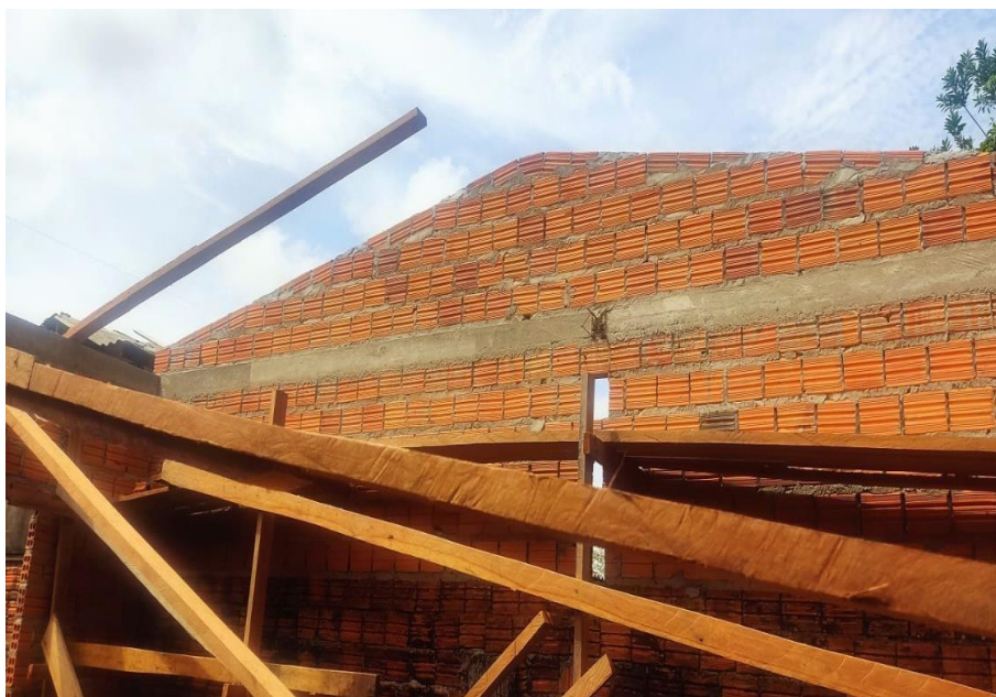
Figura 5 – Construção de uma casa e telhado
