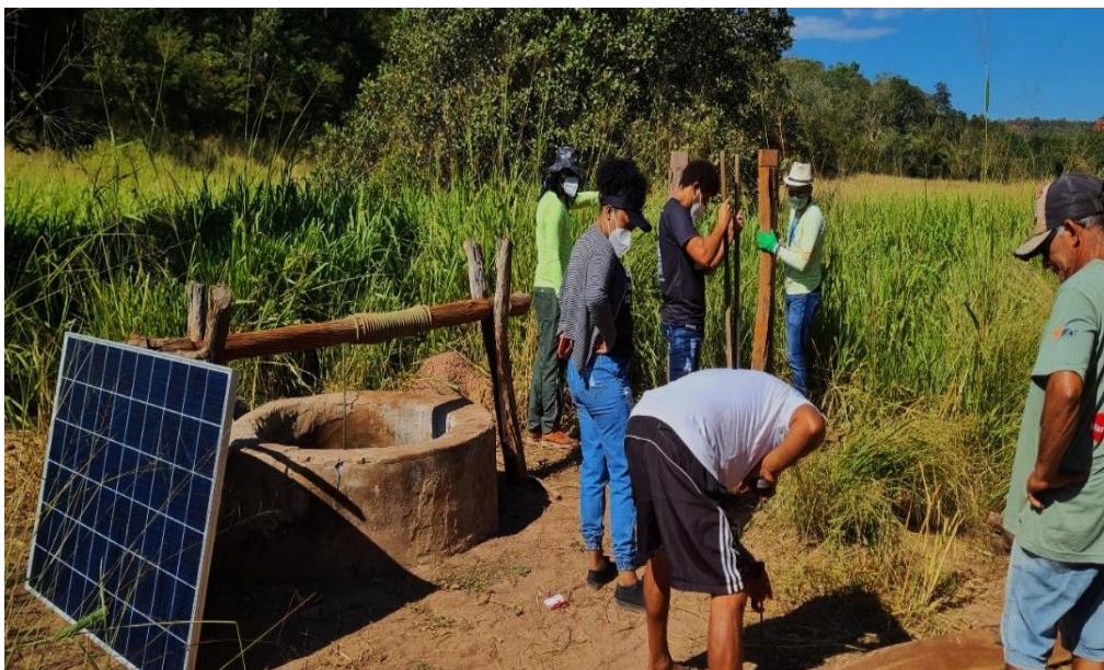
Imagem 2 – Implantação de Placa Solar no Poço Artesanal em Laranjeiras
