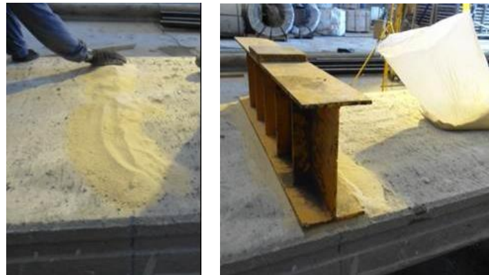
Figura 13 - Camada de regularização para apoio da viga de transferência (Pinheiro, 2014)
