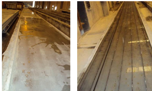
Figura 6 - Preparação da pista de concretagem (Pinheiro, 2014)
