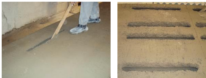
Figura 9 - Preparação para o preenchimento de alvéolos (Pinheiro, 2014).
