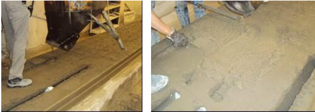
Figura 10 - Procedimento para preenchimento dos alvéolos (Pinheiro, 2014)
