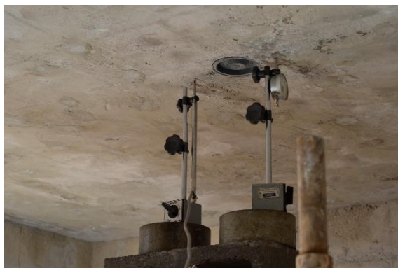
LVDT (transdutor de medição de deslocamento linear) e RC (Relógio comparador).
