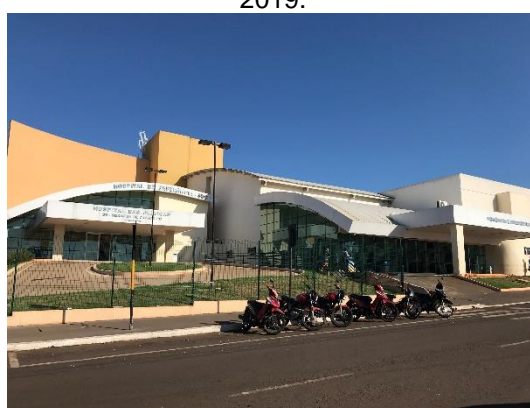
Figura 16 - Jataí (GO): Hospital das Clínicas, 2019.
