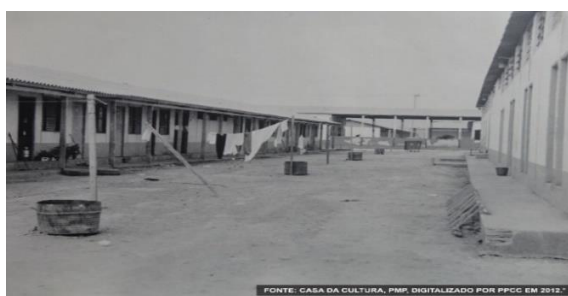
Figura 2 - Palmas: alojamentos provisórios para trabalhadores
