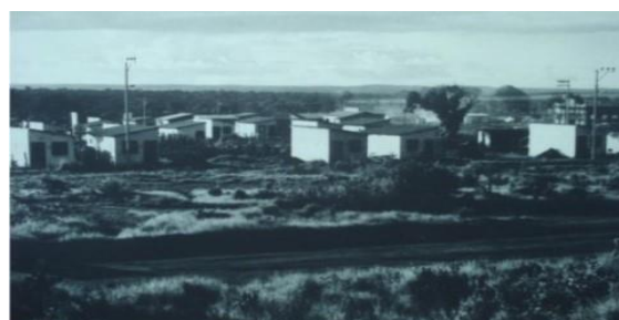
Figura 5 - Palmas: vista parcial do loteamento Jardim Aurenny I
