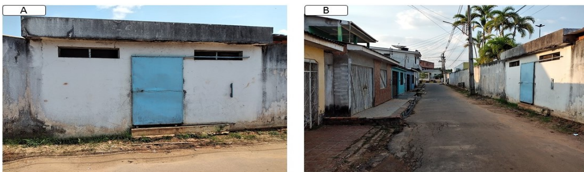
Figura 4: Lixeira externa do hospital. A) frente da lixeira sem a identificação do local e o portão externo que dá acesso a coleta dos resíduos. B) localização próximo das residências. Fonte: Autores, 2020.
