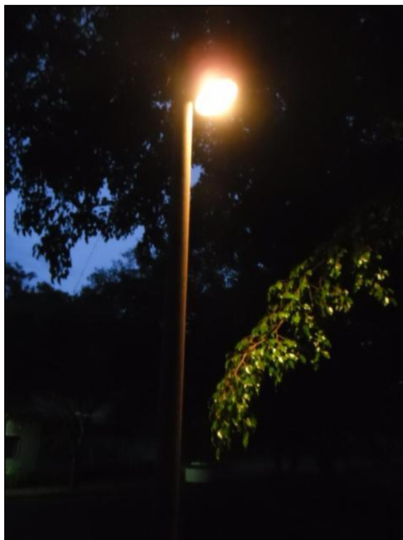
Fotografia 6 - Poste de iluminação, Parque do Mocambo.
