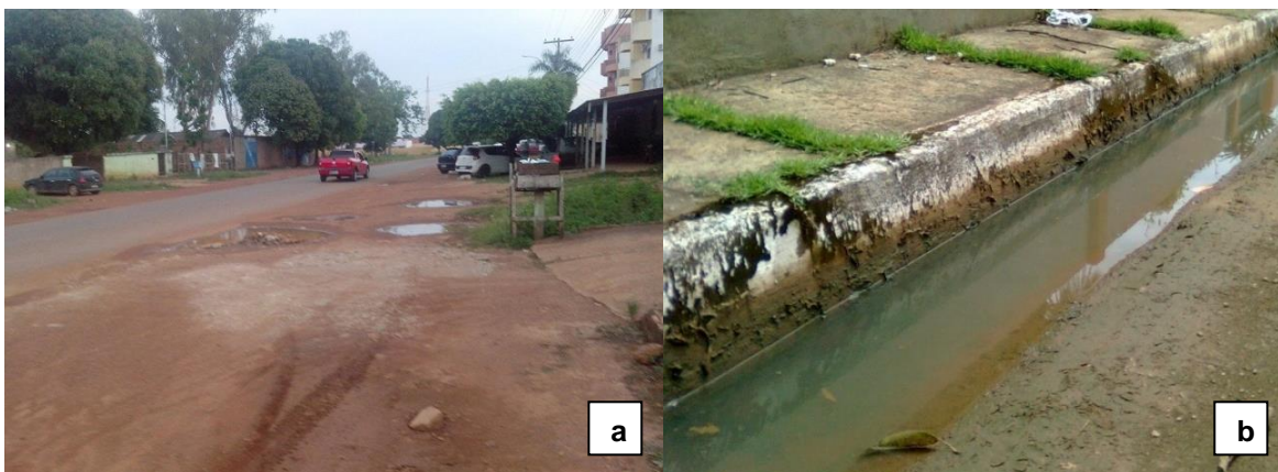
Figura 7 - Ausência de asfalto e rede de drenagem em rua da área central de Porto Velho (a); acúmulo de água após chuva (b)
