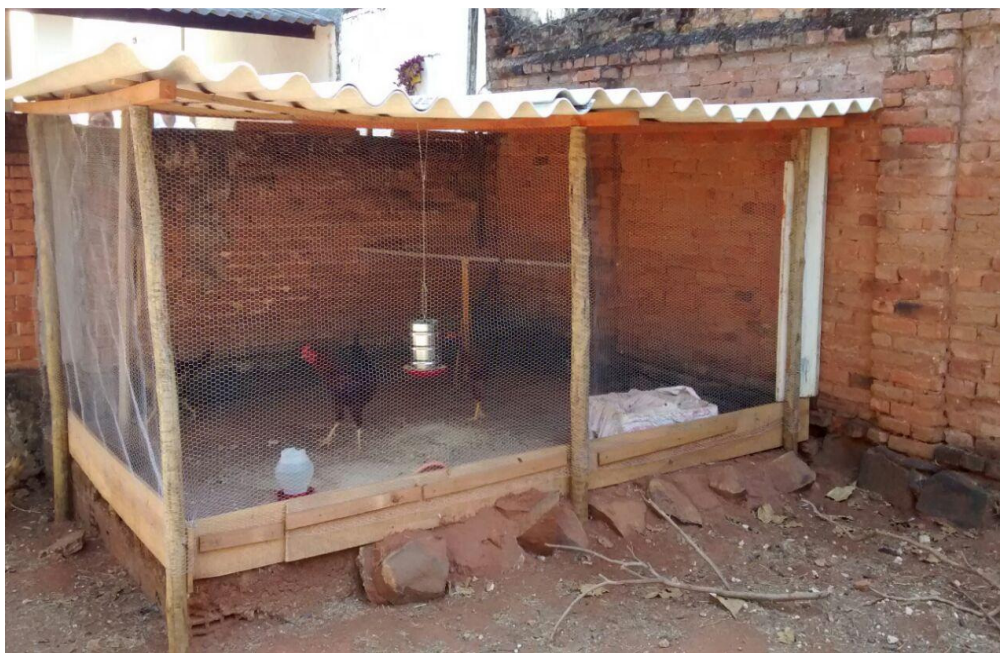
Figura 6 - Foto do galinheiro após a construção
