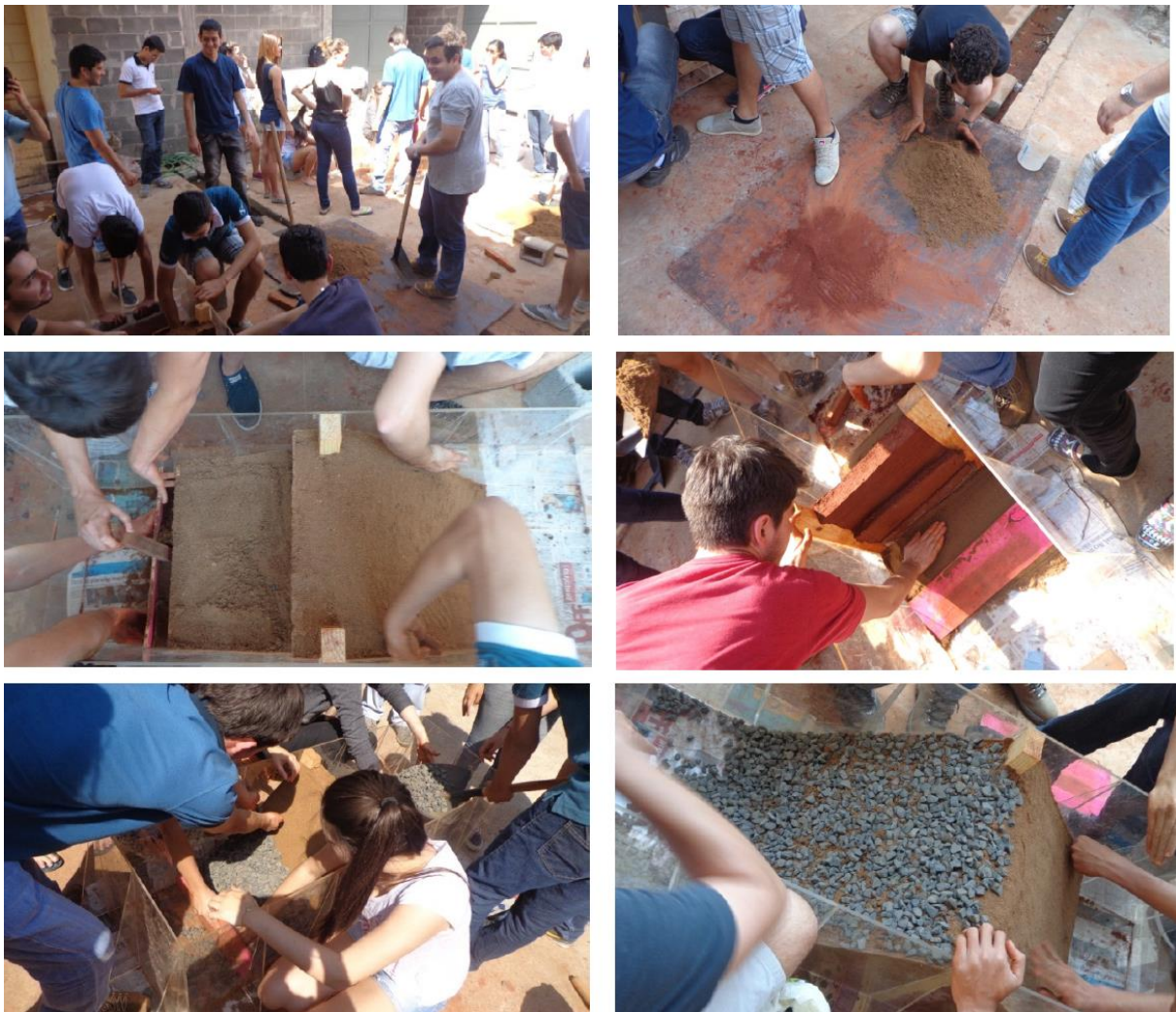
Figura 2 - Construção dos protótipos das barragens pelas equipes. Fonte: GEOCOMPET (2014).
