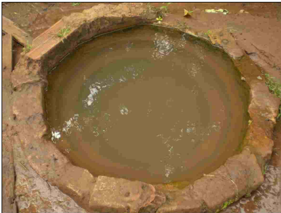
Foto 4. Bairro Mirim: canalização da água em nascente no vale do Córrego Pirapitinga. Fonte: Trabalho de campo/2009.
