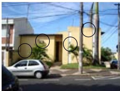
Figura 22: Fachada atual com destaque nas alterações descaracterizantes – cobertura, vedação do acesso, inserção de ar condicionado e luminárias – Res. Nelson Vasconcelos
