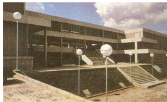
Fig. 14: Entrada principal e conjunto de escadas_Escola Sesi-Senai_ Rino Levi Arquitetos Associados SC Ltda. Fonte: Projeto, n.111, 1988.
