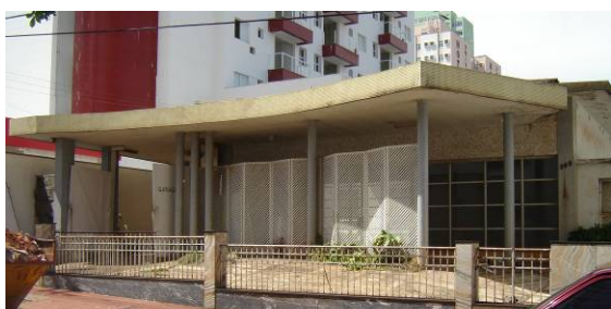
Fig. 01: Residência Benedito Modesto de Sousa, Uberlândia _ Arquiteto João Jorge Coury
