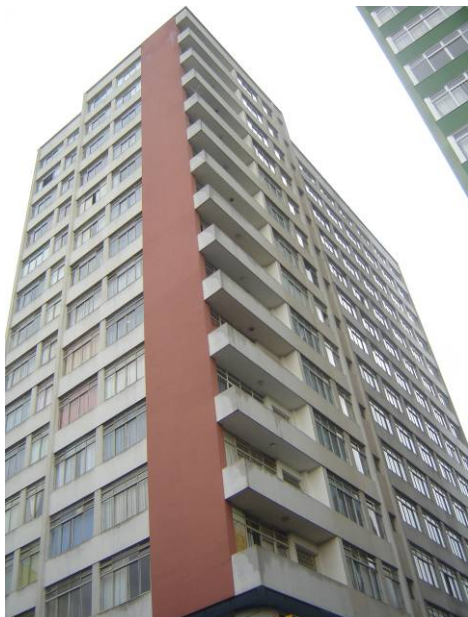
Fig. 17: Edifício Tubal Vilela, Uberlândia _ Arquiteto Ulbiano Muniz Foto: arquivo da pesquisa
