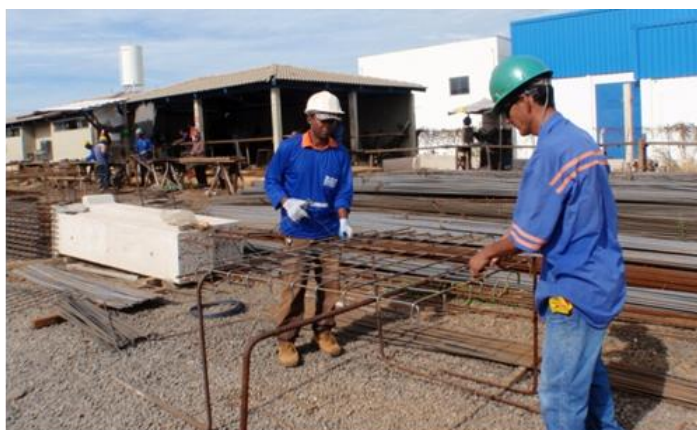
Figura 7 – Estocagem, corte, dobra e montagem das armaduras utilizadas na fabricação do pré-moldado.
