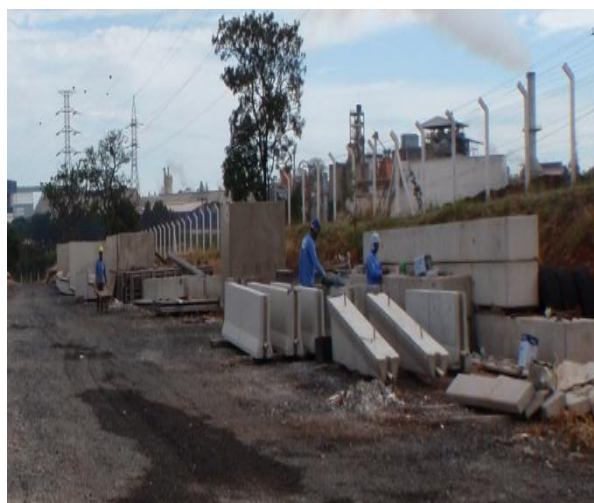
Figura 11 – Área lateral para armazenamento dos elementos pré-moldados.
