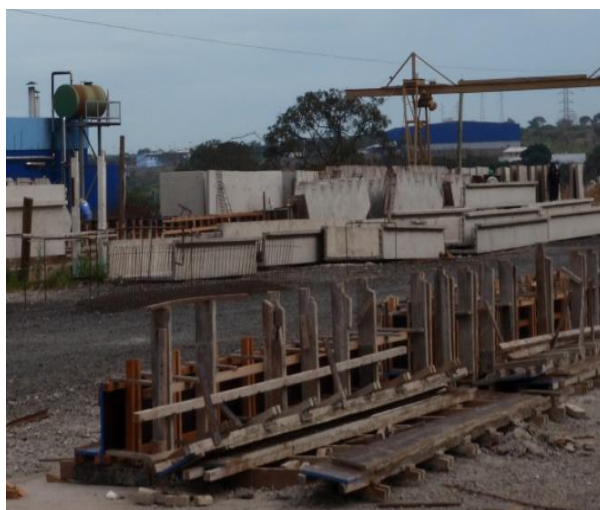
Figura 10 – Berço de concretagem de elementos variados de pequeno porte.
