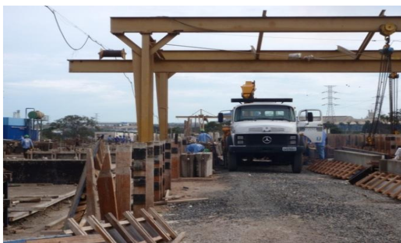
Figura 9 – Vista frontal dos dois berços de concretagem de elementos variados de grande porte.
