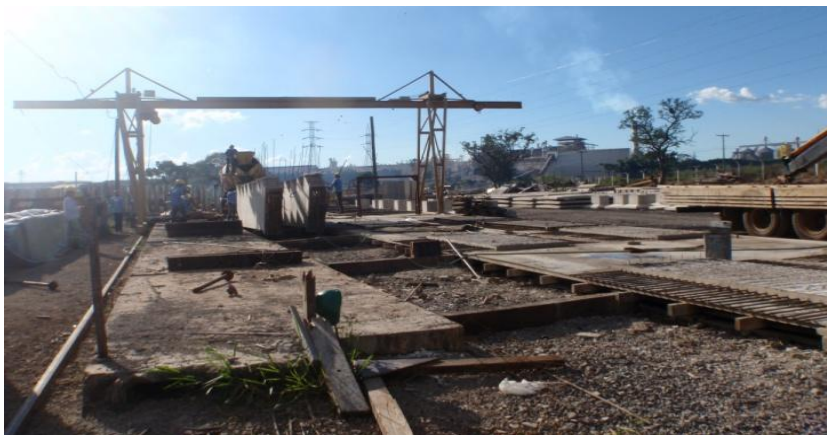
Figura 8 – Vista dos dois berços de concretagem centrais.
