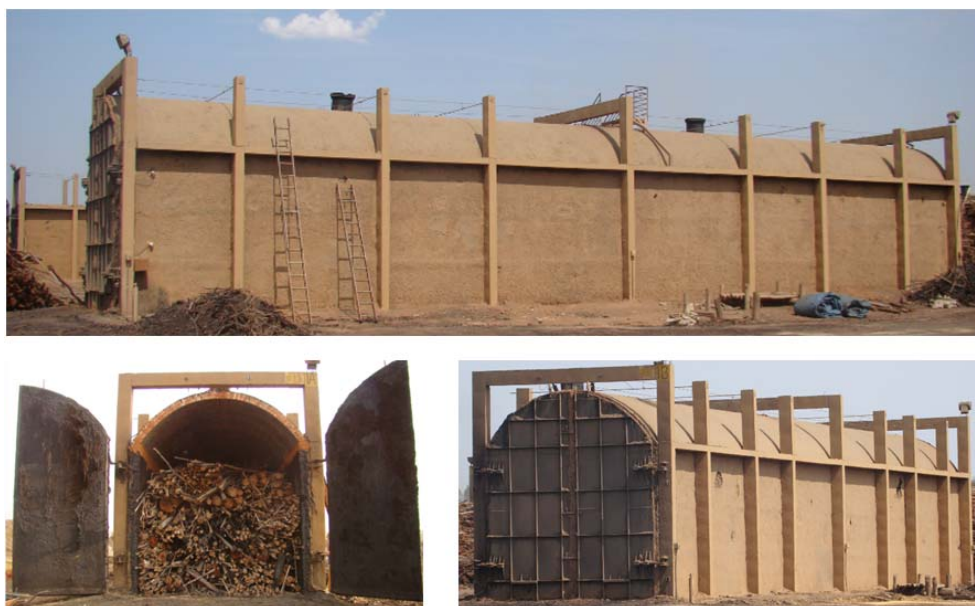
Figura 3.1 – Forno típico de Alvenaria modelo RAC220.
