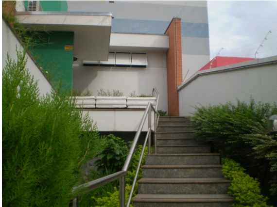
Figura 14: Destaque para a parede de tijolos à direita.
