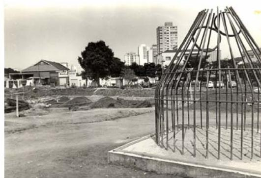
**Fig. 08:** Foto da construção do Fórum de Uberlândia com destaque para a armadura dos pilares, década de 1970.
