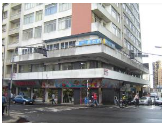
Figura 13: Detalhe do Pavimento Térreo (Comercial) do Edifício Tubal Vilela, Uberlândia – MG, Arquiteto: Ulbiano Muniz Data de inauguração: out/1960 Fonte: Arquivo da Pesquisa
