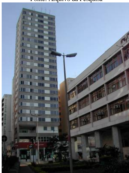
Figura 25: Edifício Leopoldino de Oliveira, Uberaba – MG, Arquiteto: Pontual Arquitetos Associados Ano de inauguração: 1973 Fonte: Arquivo da Pesquisa
