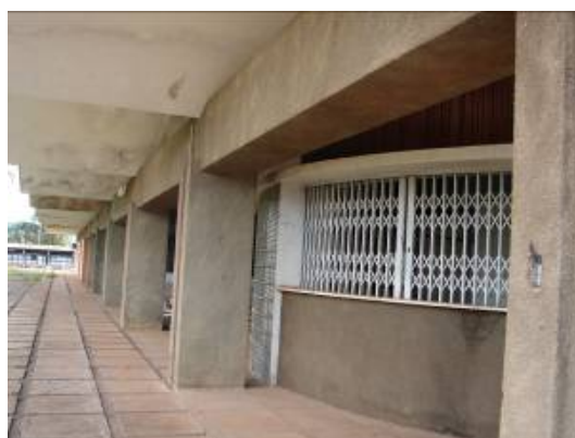
Figura 11: Vista Lateral do Centro Comercial da Vila Operadora de Jaguará, Sacramento – MG, Projeto desenvolvido por arquitetos do Isvaú – Departamento de Engenharia Civil da Cemig Fonte: Arquivo da Pesquisa
