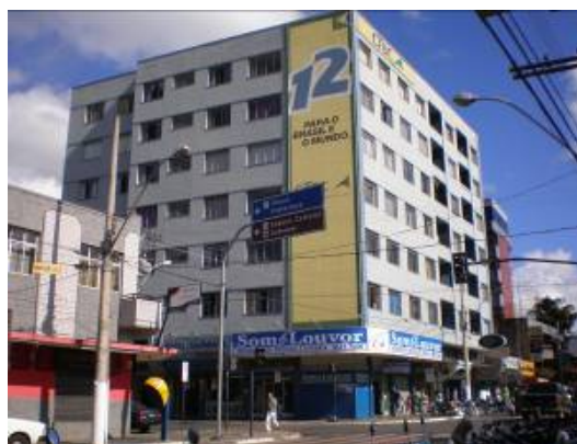
Figura 15: Edifício Alvorada, Patos de Minas – MG, Arquiteto não identificado Período de construção: década de 1960 Fonte: Arquivo da Pesquisa
