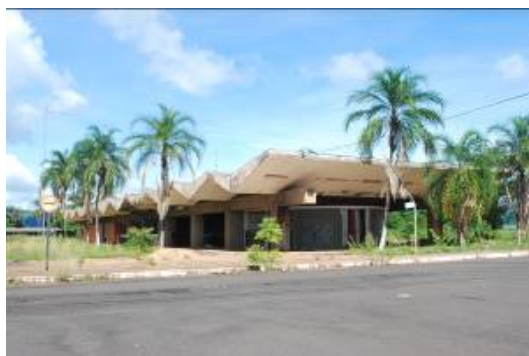
Figura 10: Centro Comercial da Vila Operadora de Jaguará, Sacramento – MG, Projeto desenvolvido por arquitetos do Isvaú – Departamento de Engenharia Civil da Cemig Fonte: Arquivo da Pesquisa
