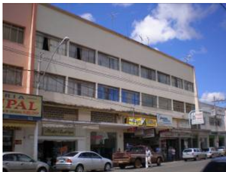
Figura 19: Galeria São Geraldo, Patos de Minas – MG, Arquiteto não identificado Fonte: Arquivo da Pesquisa
