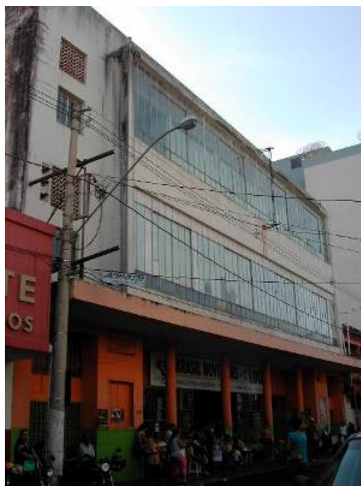
Figura 09: Cine Capitólio, Ituiutaba – MG, Arquiteto não identificado Fonte: Arquivo da Pesquisa
