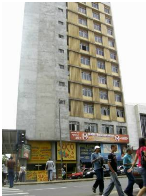
Figura 21: Edifício Everest, Uberaba – MG, Arquiteto não identificado Fonte: Arquivo da Pesquisa
