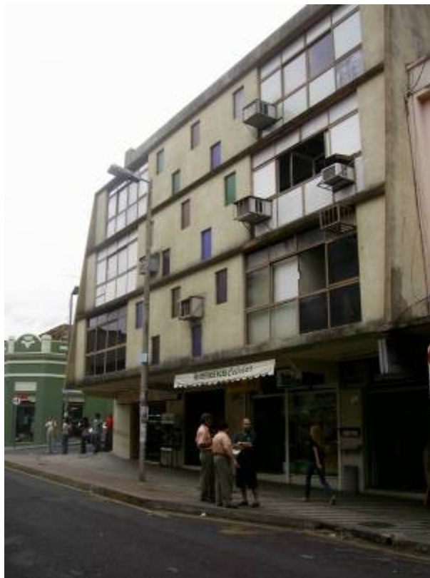
Figura 28: Galeria Fausto Salomão, Uberaba – MG, Arquiteto: Germano Gultzgoff Ano de inauguração: 1972 Fonte: Arquivo da Pesquisa
