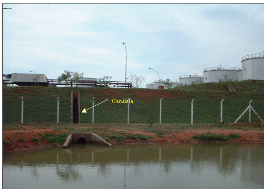
Figura 4.1 – Foto da lagoa mostrando a canaleta e o bocal de descarga do efluente na mesma.
