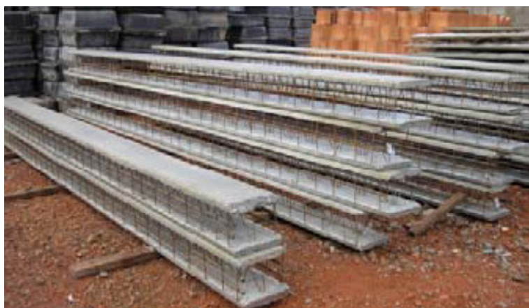
Figura 1 – Painéis duplos treliçados.
