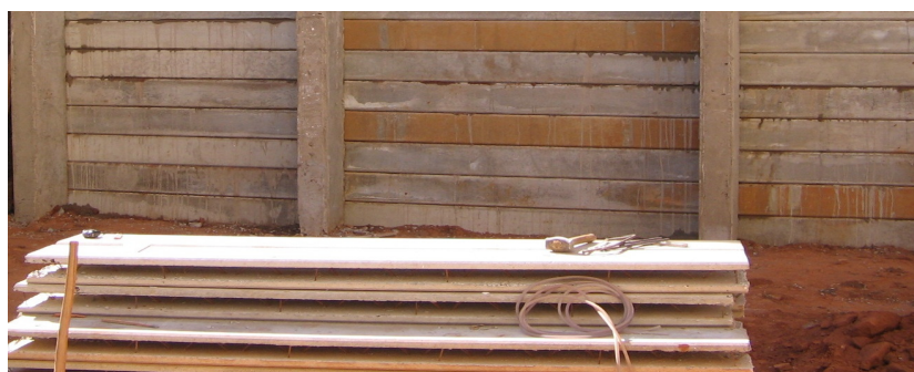
Figura 2 – Aplicações de painéis duplos treliçados em muros de arrimo.
