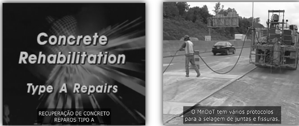
Figuras 7 e 8 — Capturas de pantalla con los subtítulos quemados en el vídeo Concrete Rehabilitation Type A Repairs .
