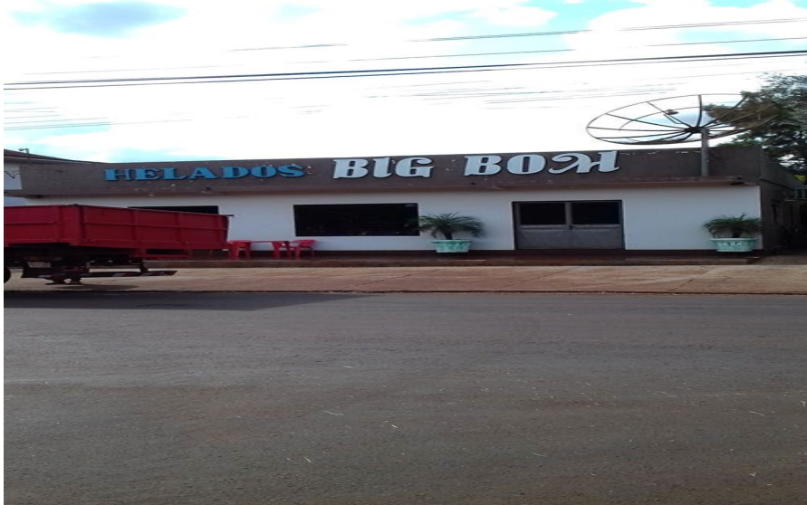
Figura 4 – Fachada Helados Big Bom.
